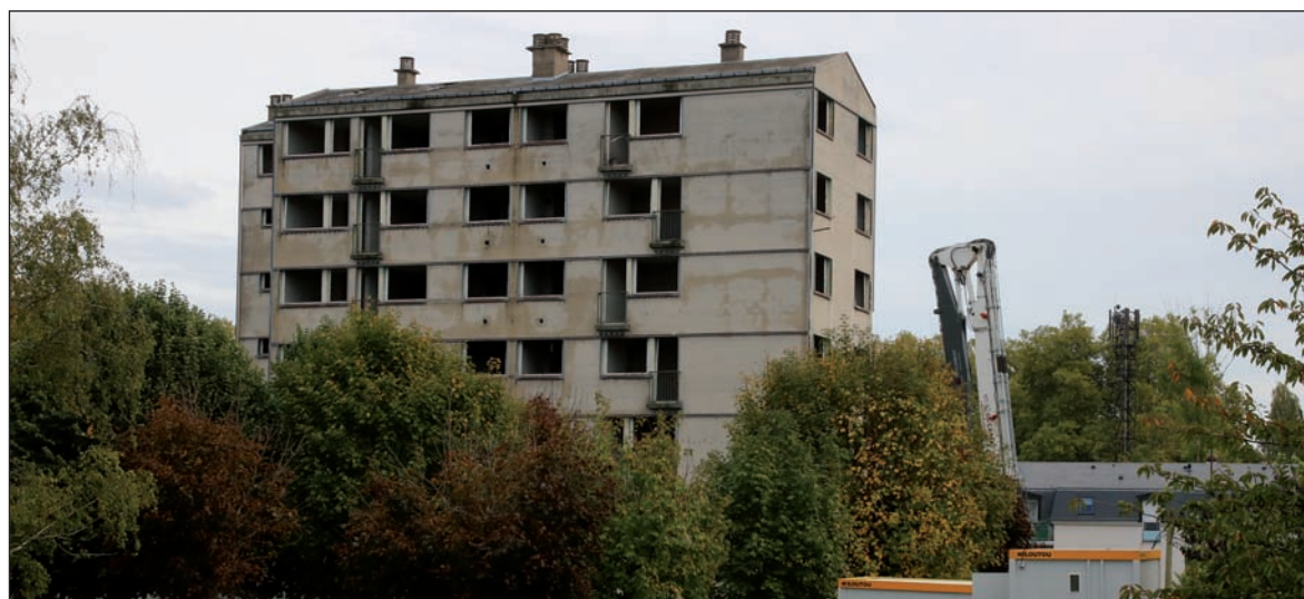
Fig. 18 Bourges. Quartier du Beugnon, au sud de la ville : démolition d'habitat social (Cliché G. Dinéty 2022).
